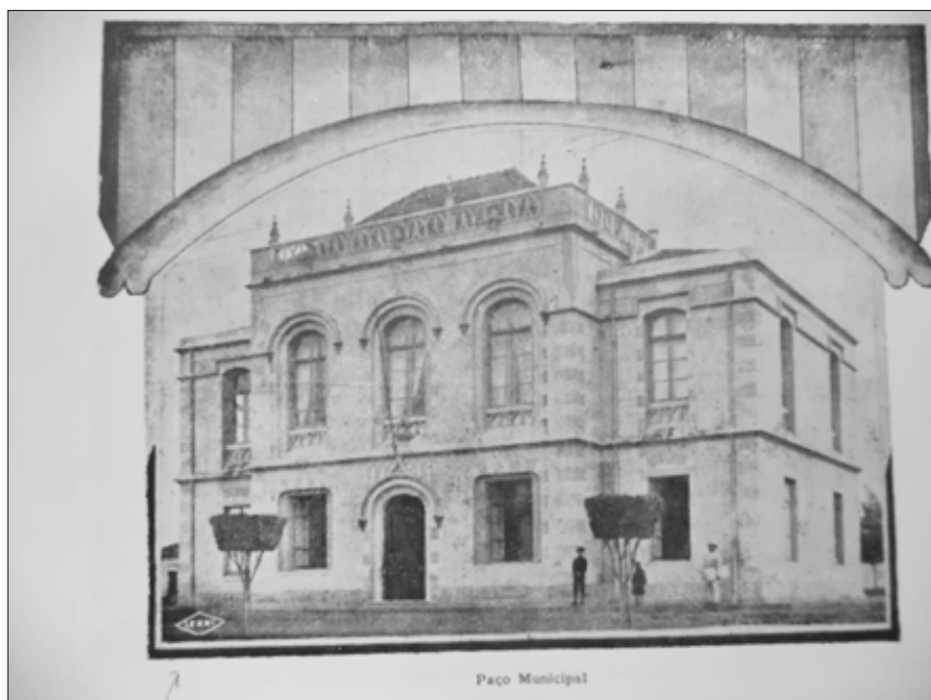
FIGURA 2 – Fotografia original da Câmara Municipal de Araraquara, executada por LEMMI (assinatura à esquerda) numa composição em close ligeiramente ascensional e diagonal. Destaque-se, ainda, a moldura que adorna a imagem, inserida posteriormente por Antonio M. França, organizador do álbum
