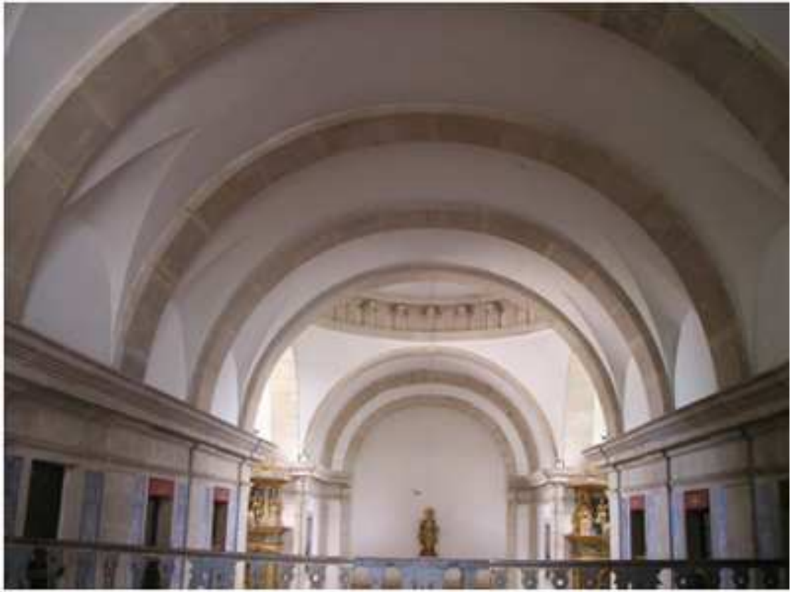
FIGURA 1 - Foto da abóbada central de estudo.
