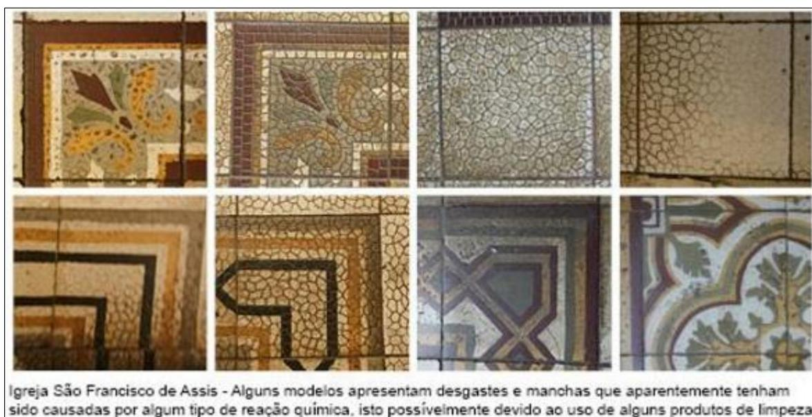
Figura 5 – Processo de desgaste dos Ladrilhos Hidráulicos.
