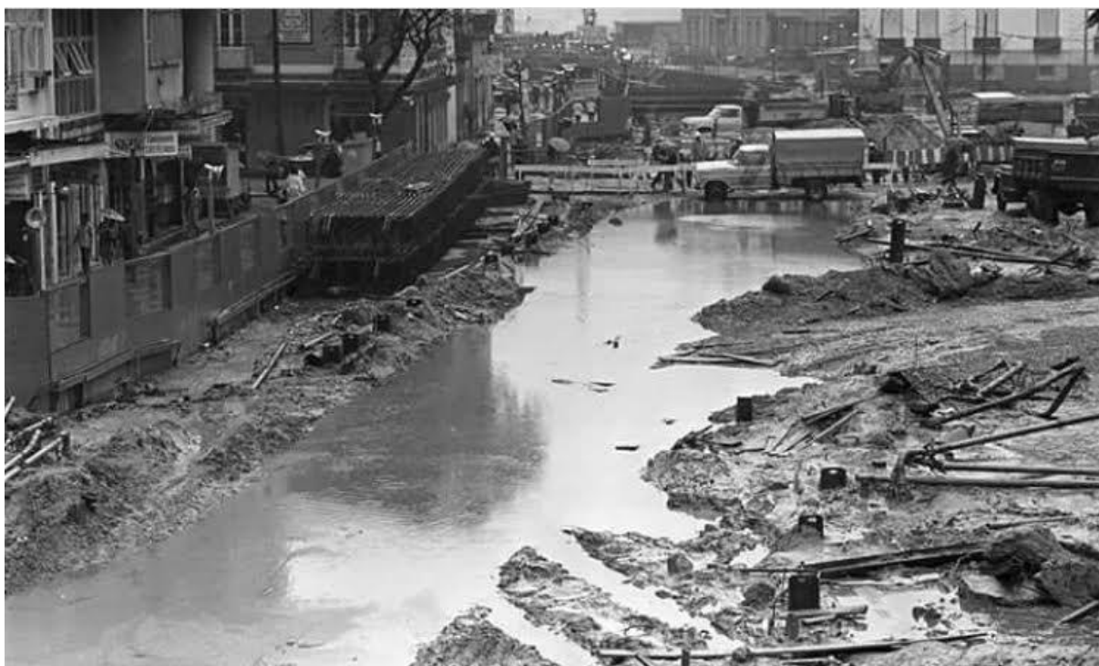
FIGURA 3 – Rua do Catete, 1976, durante as obras do metrô na altura da Rua Ferreira Viana. Fonte: Arquivo Nacional
