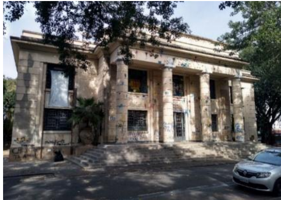
Figura 9 – Antigo Fórum Velho aguardando obras de restauro Fonte: acervo do autor, 2019
