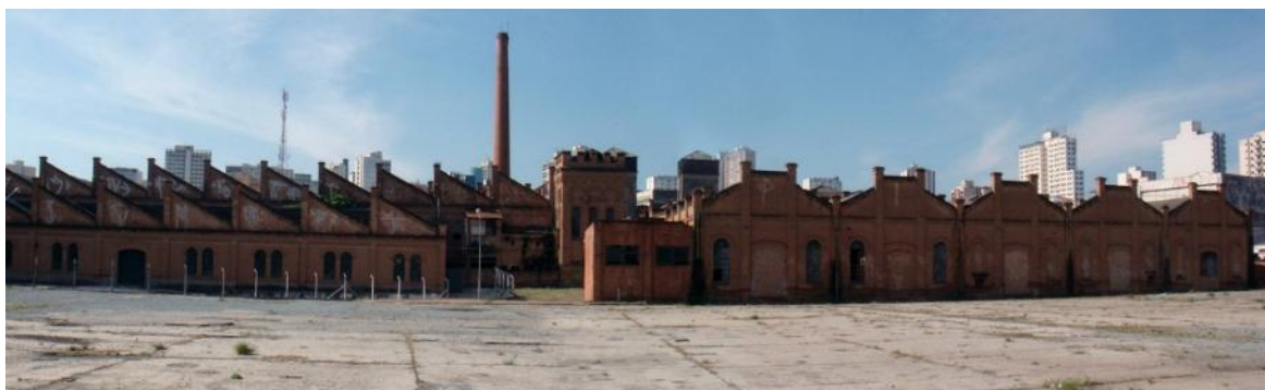
Figura 2 – Fábrica Nossa Senhora da Ponte, propriedade da Cianê Foto: autor, 2009
