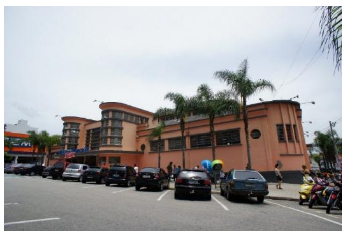
Figura 3 – Mercado Municipal, primeiro bem tombado pelo Município Foto: autor, 2012
