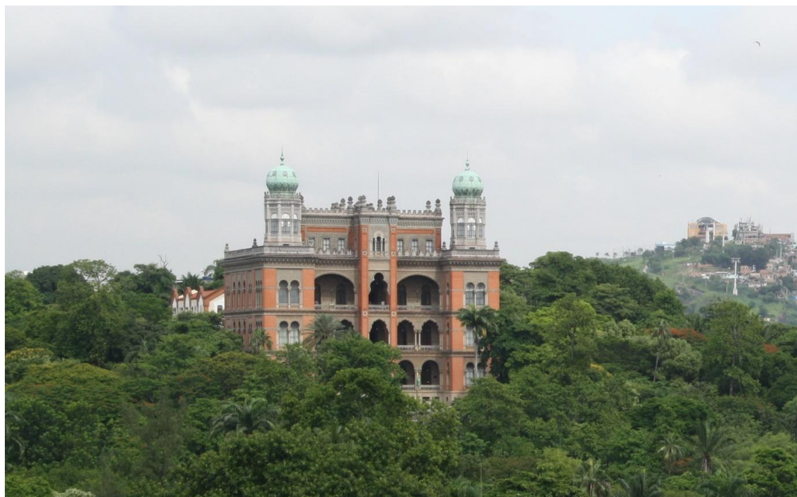
Figura 2 – Vista do Pavilhão Mourisco. Foto: Carla Coelho, 2020.
