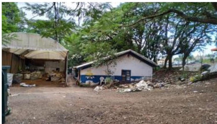
Figura 6 - Antigo edifício da Escola São Paulo em Holambra ao centro em maio de 2019. Fonte: Acervo pessoal.
