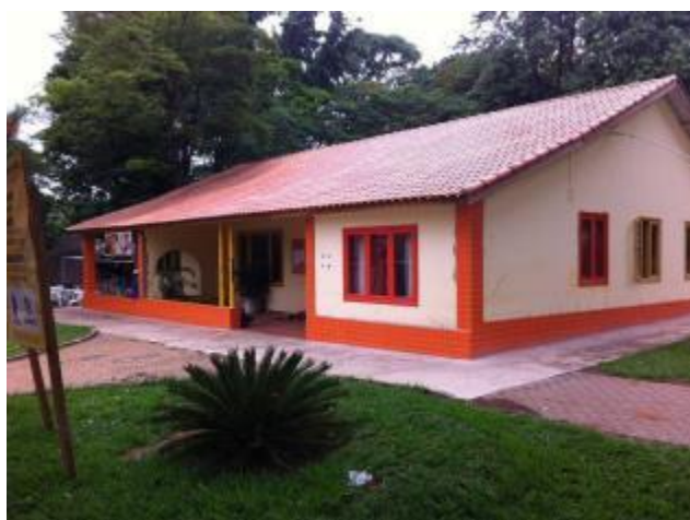
Figura 5 - Casa dos presidentes da Cooperativa em reforma, na Praça dos Pioneiros, em 2014. Fonte: Acervo pessoal.
