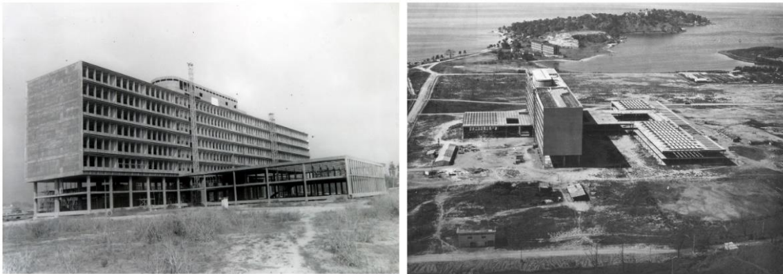
Figura 3. Fotografias do prédio da Reitoria da UFRJ. Projeto de Jorge Machado Moreira. Fonte: Núcleo de Pesquisa e Documentação/ FAU – UFRJ. Disponível em: http://arqugia.com/obra/edificio-reitoria-ufrj/?lang=ptbr
