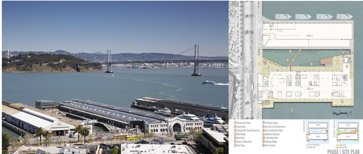
Imagem 3: Vista aérea dos galpões adaptados - Bruce Damonte Photography e Planta Baixa do projeto do museu – ehdd . Fontes: the Journal of the American Institute of Architects e Archdaily
