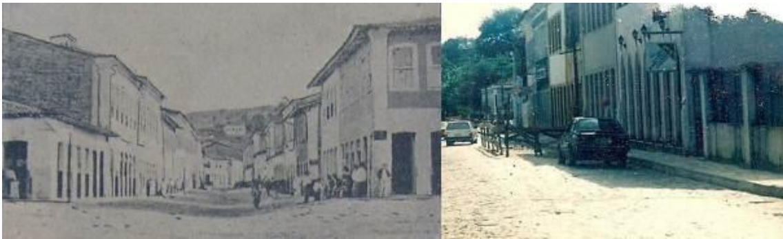
Figura 2 – Comparação entre a Rua Direita em 1920 e 1970.
