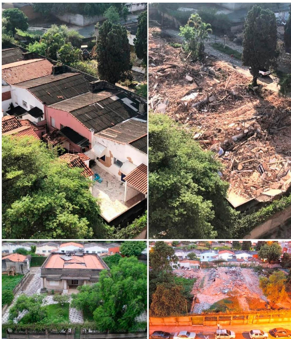
Figura 3 – Acima “Jardim Bertina” (fachada posterior). Abaixo: “Casarão Stilitano” (fachada frontal). Ambos antes e após suas demolições. Fontes: Acervo de Paulo Pontes (2020) e de “Sorocaba através da História” (2020).
