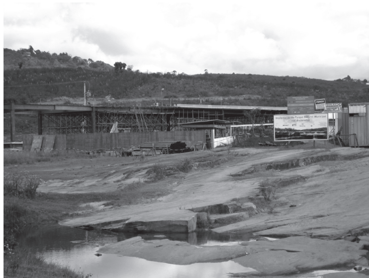
Figura 7: Foto das obras de infra-estrutura do Parque. Bairro Morro de São Sebastião, Ouro Preto/MG.
