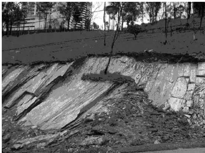
Figura 16 – Blocos de xisto susceptíveis a escorregamento planar - Talude Rio acima .
