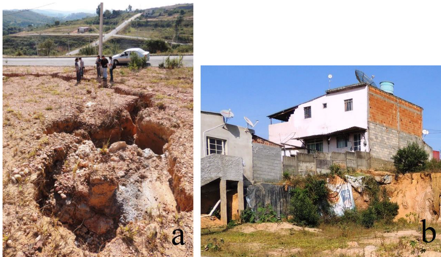
Figura 6: Processos erosivos em loteamentos no Setor Senhor dos Montes (a) e no Setor Fábricas (b)
