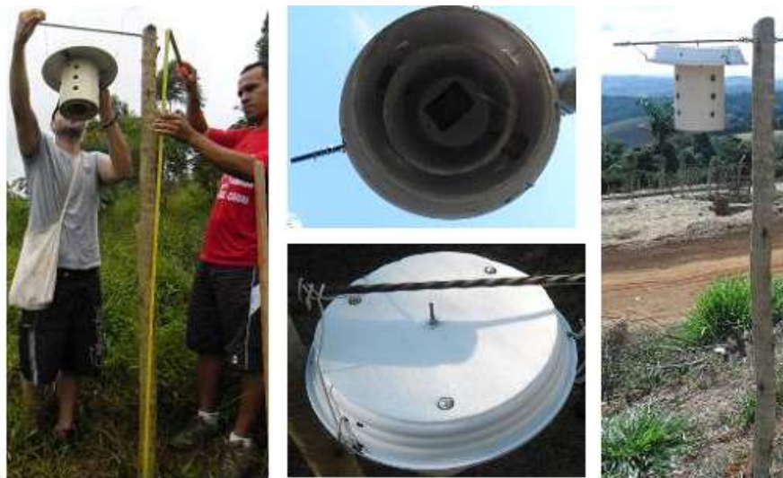
Figura 5 Instalação e fixação dos miniabrigos meteorológicos em campo, contendo os termohigrômetros dataloggers Hobo U10-003.
