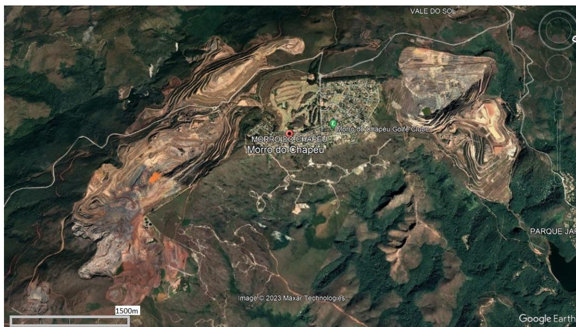
Figura 4. O condomínio de luxo Morro do Chapéu circunjante a duas cavas de mineração (Mina Capitão do Mato), em Nova Lima/MG
