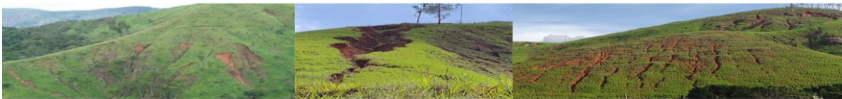
Figura 4 - Feições erosivas no município de Timóteo-MG, janeiro de 2023.
