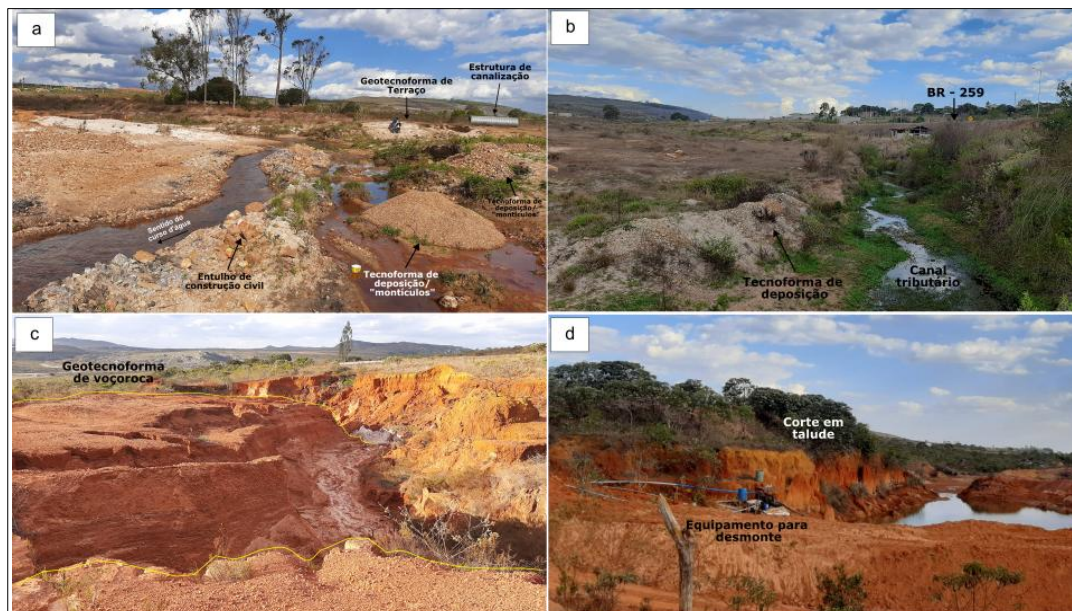
Figura 5. a) Visão geral do fundo de vale, alto-médio curso b) Formas tecnogênicas entorno de canal tributário do ribeirão Datas c) Vista de Geotecnóforma de Voçoroca em contexto de encosta d) Área de desmonte com destaque para Tecnoformas de Escavação.
