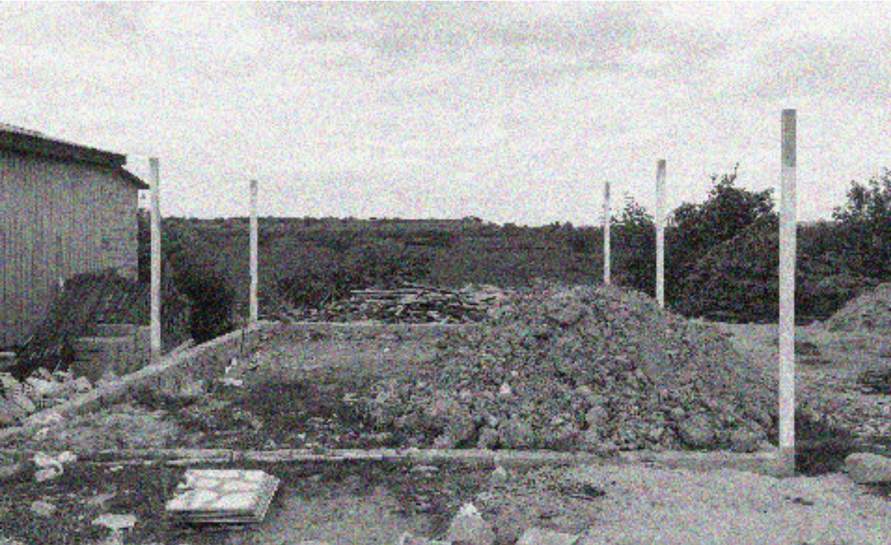
Figura 8. Pilares e fundações da nova associação de moradores da Vila Dique. (Foto: EMAV, 2018)
