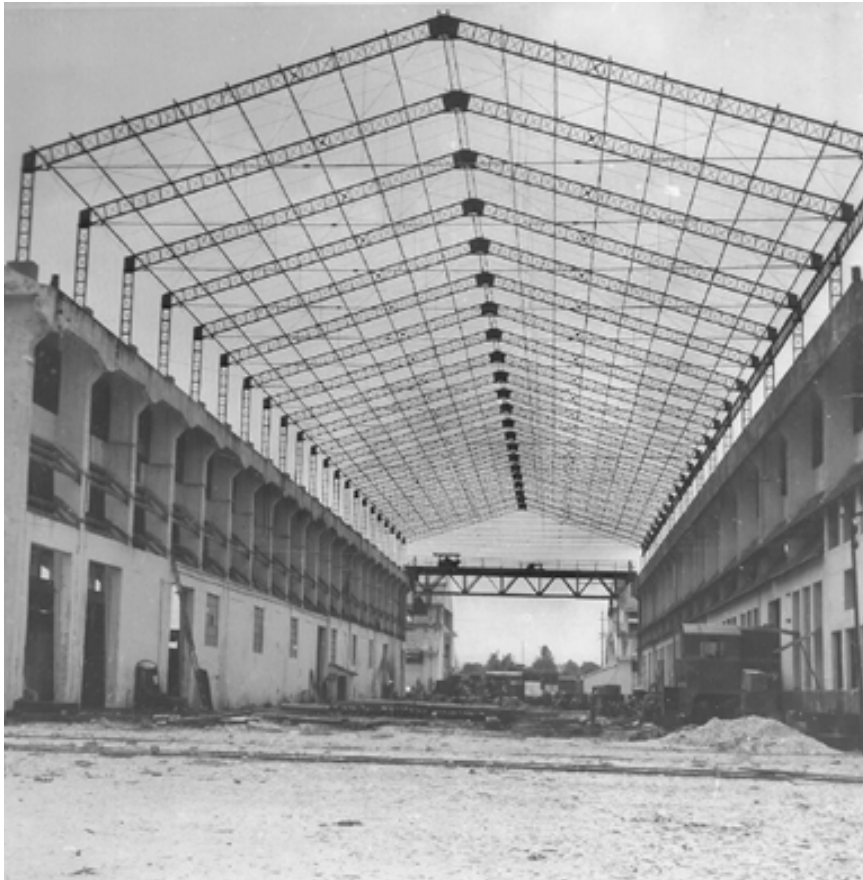
Figura 12: Construção de galpão nas Oficinas do Urubu (1975)
