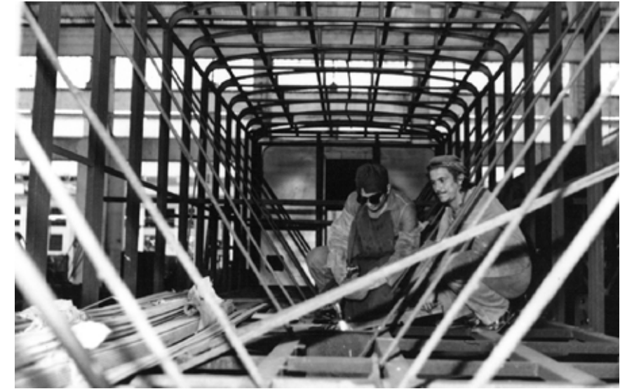
Figura 11: Construção manual de carro de passageiros típicos do trem “Sonho Azul” (1975) Fonte: Livro Descaminhos de Ferro, Vol. 2 (2012)
