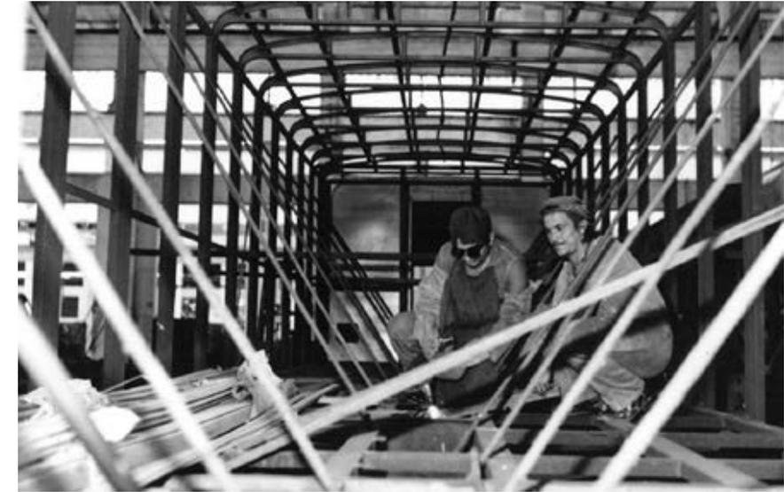
**Figura 11:** Construção manual de carro de passageiros típicos do trem “Sonho Azul” (1975)
