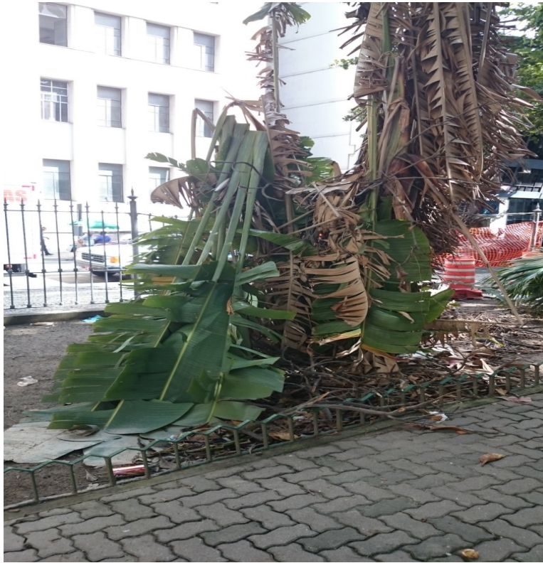
Figura 8: Na parte lateral da praça encontramos muita sujeira, lixo e restos de entulho de uma obra mal acabada da prefeitura. Sem contar no buraco que a grade que contorna a praça apresentava.
