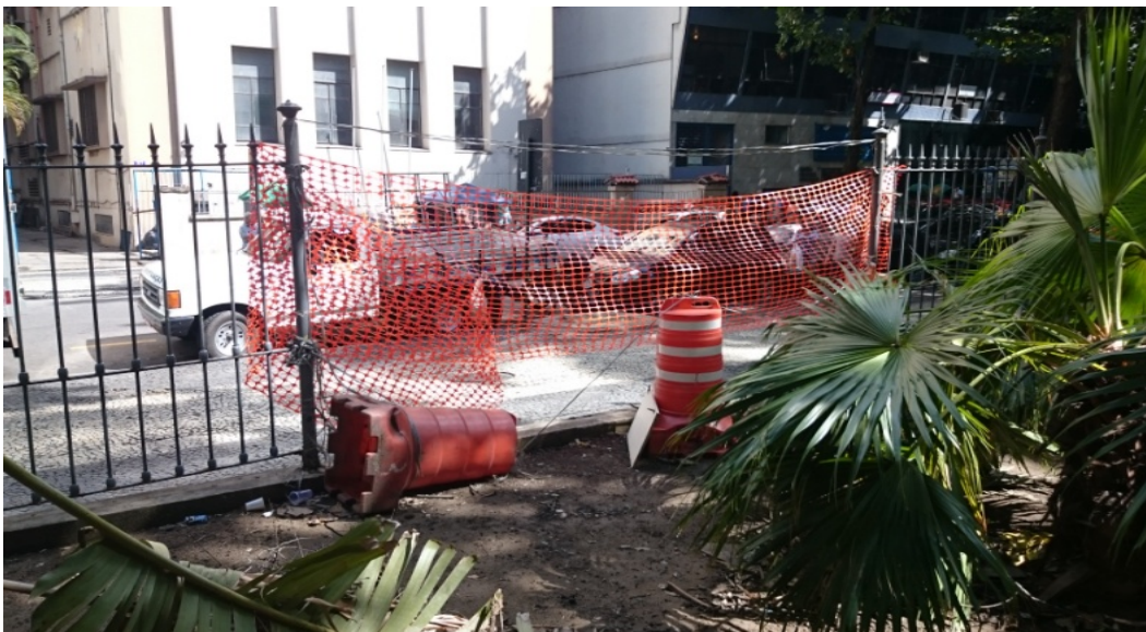
Figura 9: Na parte lateral da praça encontramos muita sujeira, lixo e restos de entulho de uma obra mal acabada da prefeitura. Sem contar no buraco que a grade que contorna a praça apresentava.
