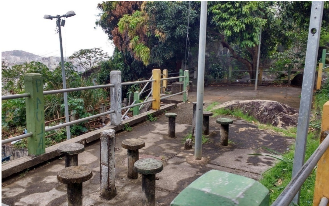
Foto 6: Foto tirada no dia 01/11/2017, os bancos embutidos estão danificados, não há gradeamento da praça.
