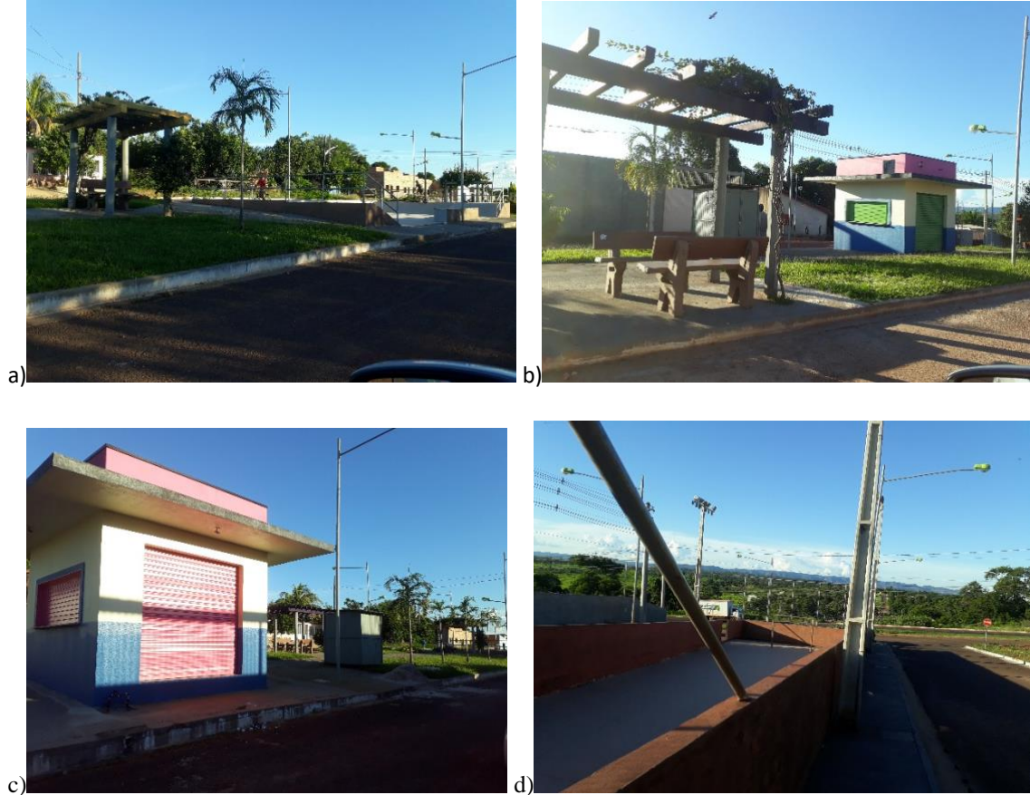
Figura 4: Espaços de lazer disponíveis no primeiro logradouro da Avenida Perimetral/Paulo Luís da Assunção a) Pista de Skate; b) bancos e pergolados; c) Quiosque e banheiro; d) Quadra de concreto.
