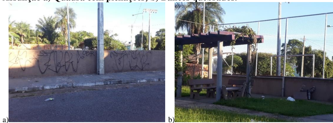
Figura 12: O mau uso dos espaços de lazer da Avenida Perimetral / Paulo Luís da Assunção a) Quadra com pichações; b) Bancos quebrados.
