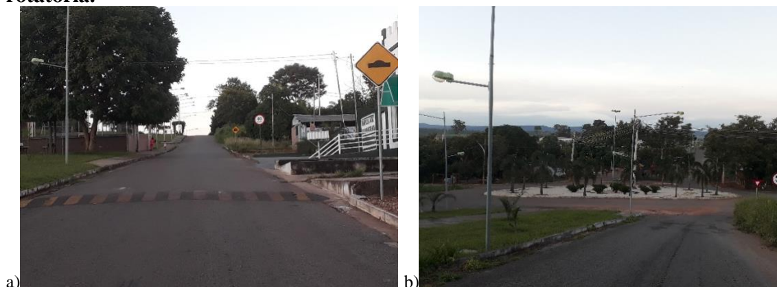
Figura 10: Espaços na Avenida Perimetral / Paulo Luís da Assunção que foram instaladas sinalizações de transito a) Quebra Mola, placas indicando quebra mola, velocidade máxima e indicação de subida; b) Placas de sinalização indicando a rotatória.
