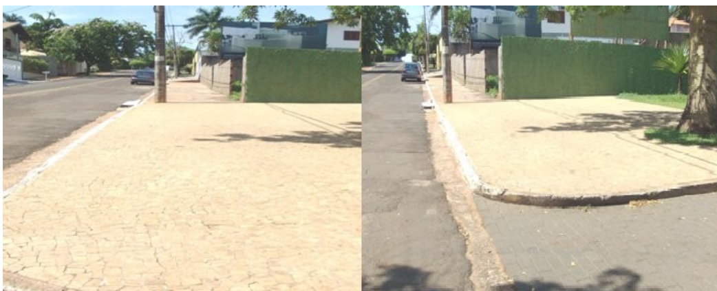
FIGURA 1 – Largura do passeio público e ausência de rampas de acesso ao Parque em 17 de maio de 2010.
