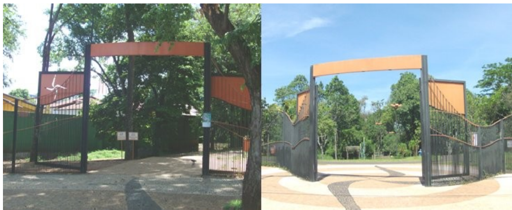
FIGURA 3 – Portões de acesso principal e secundário em 17 de maio de 2010.
