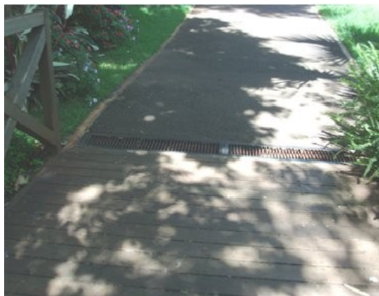
FIGURA 5 – Grelha no acesso principal em 17 de maio de 2010.
