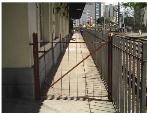
FIGURA 8: Grades na Estação Ferroviária Fonte: Arquivo pessoal, 2008.
