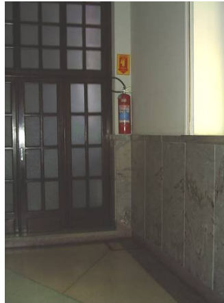
FIGURA 10: Extintor de Incêndio com sinalização direcional visual
