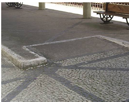
FIGURA 21: Rampa na Estação Ferroviária Fonte: Arquivo pessoal, 2008
