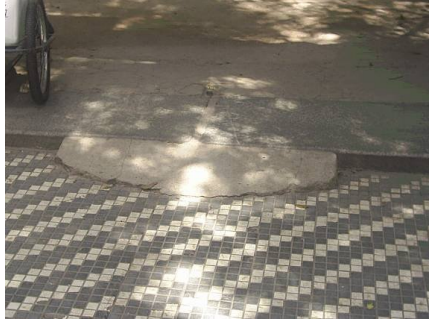
FIGURA 16: Rampa de acesso na entrada do Parque Centenário Fonte: Arquivo pessoal, 2008.
