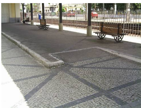
FIGURA 6: Rampa de acesso da calçada para a área superior da Estação Ferroviária Fonte: Arquivo pessoal, 2008.
