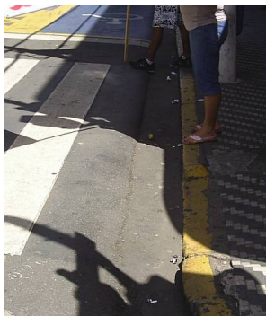
FIGURA 26: Asfalto elevado Fonte: Arquivo pessoal, 2008.
