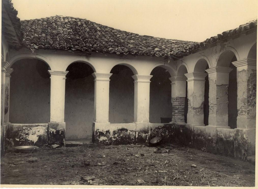
Detalhe do Pátio interno.
