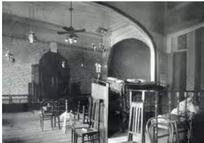
Figura 11 – Fotografia não identificado. Beth Yaacov , a mais antiga sinagoga de Manaus, edificada na Rua da Saudade. Manaus, 1820. 41
