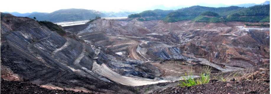
Foto 2: Barragem do Fundão esvaziada após o rompimento (Foto do autor)
