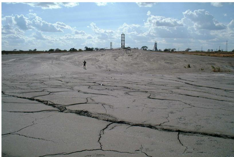
Figura 9 – Deposição de Pasta - Sistema de Torres de Deposição
