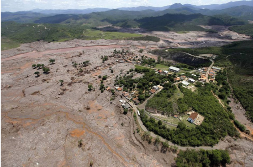
FIGURA 2- Foto aérea mostrando a devastação do distrito de Bento Rodrigues, pertencente ao município de Mariana (MG), causada pelo rompimento da barragem de Fundão, Mina de Germano/Samarco ocorrido no dia 05 de novembro de 2015. Fonte: Google.
