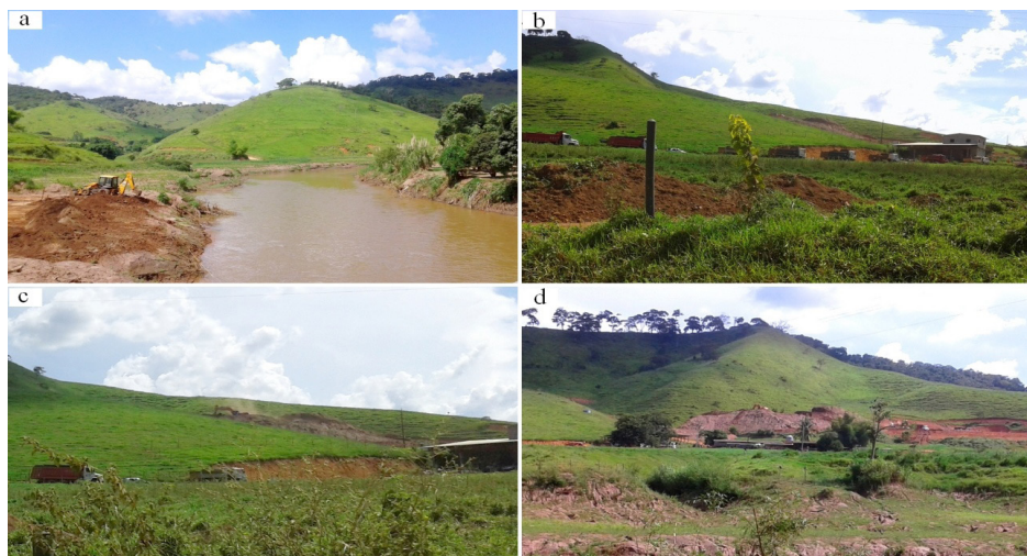
Figura 13: Remoção de sedimento da área de mata ciliar, transporte de material por caminhões e alocação do material em pilhas. Remoção do sedimento nas margens do rio (a), transporte de material para pilhas (b), construção das pilhas (c,d).
