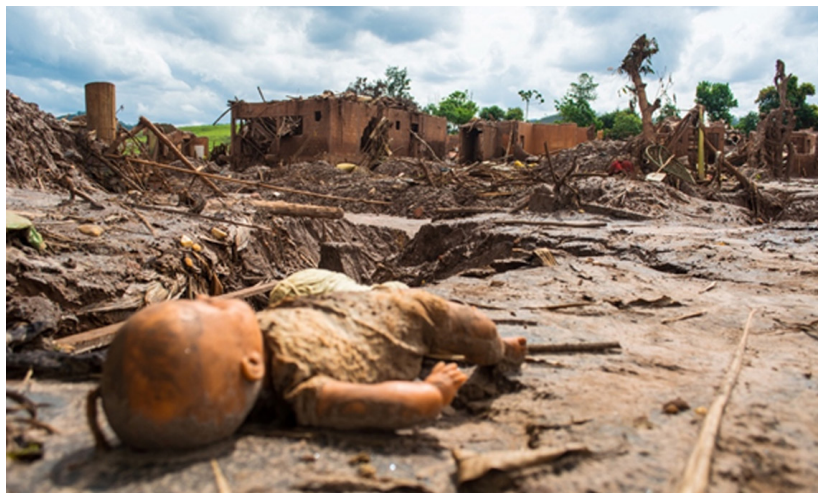
Imagem 04 - Bairro arruinado de Bento Rodrigues, Mariana – MG.
