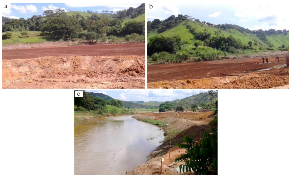
Figura 15: Aterramento, preparo e drenagem na área de plantio. Destaca-se o uso de solos exógenos (a, b) para aterramento e a presença de drenagem a área de plantio (c).
