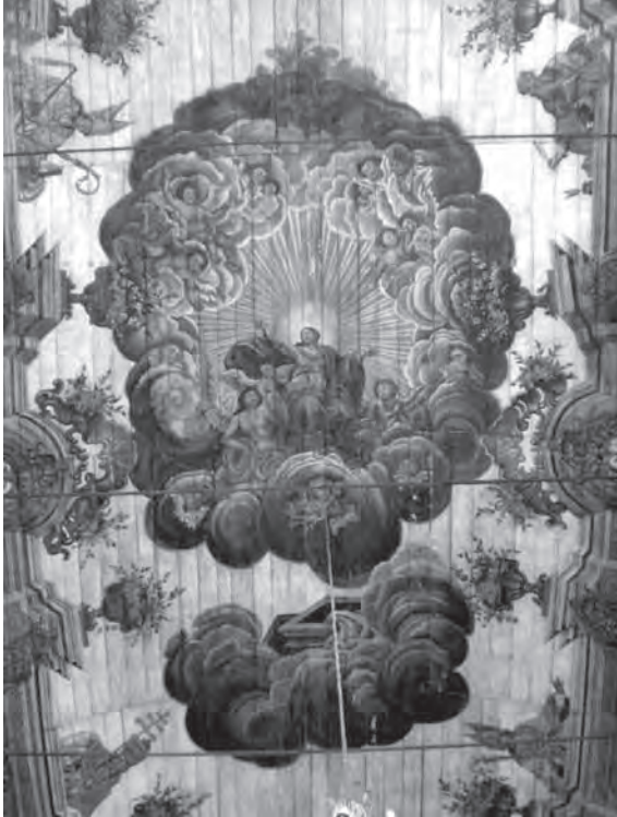
Ex.1 – Forro da nave da Matriz de Santa Luzia
