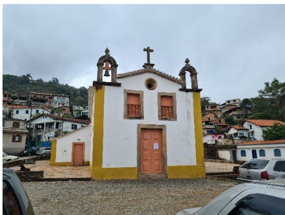
Figura 1 - Capela N.S.da Piedade
