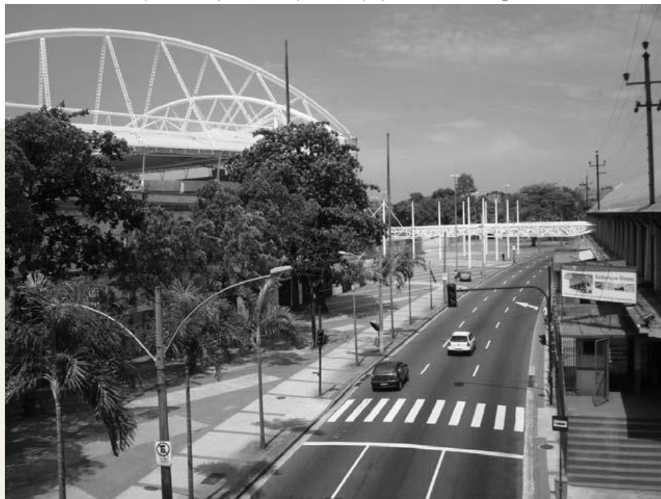
Figura 2: Estádio Olímpico, inicialmente nomeado "João Havelange", cujo custo foi de 380 milhões de reais. Atualmente, o estádio é administrado, através de uma parceria público-privada, pela equipe do Botafogo.
