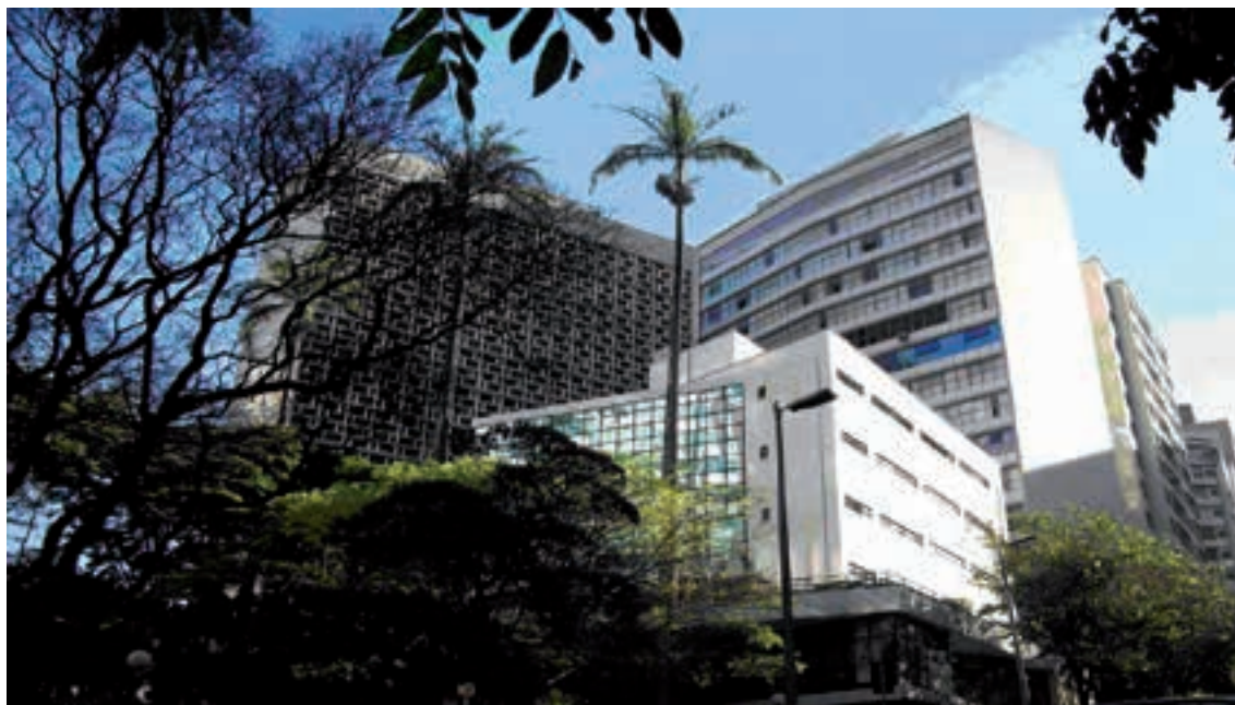
Foto 2: Prédio da Faculdade de Direito, demolido em 1958, na Praça Afonso Arinos
