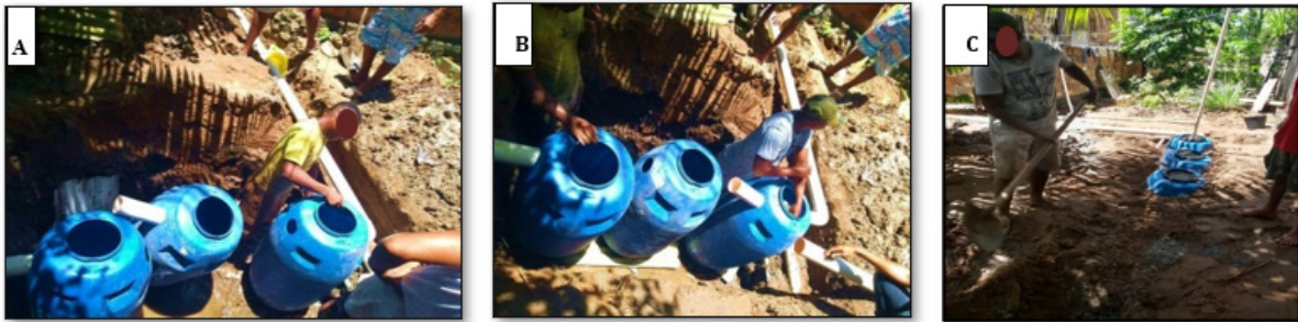
Figura 5. Participação dos moradores na construção da Fossa Séptica Ecológica na comunidade
