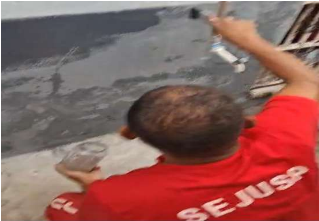
Figura 7: Aplicação da resina impermeabilizante (à base de isopor)
