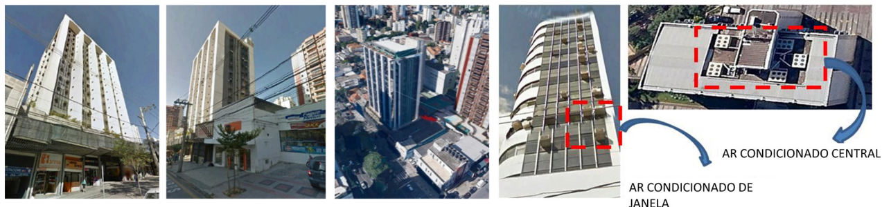
Figura 2 - Edifício Contorno Plaza, imagens capturadas para análise no DMA
