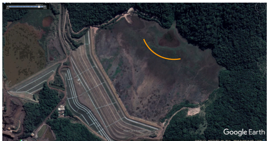
Figura 8 -Imagem de satélite da barragem I em 10/06/2017
