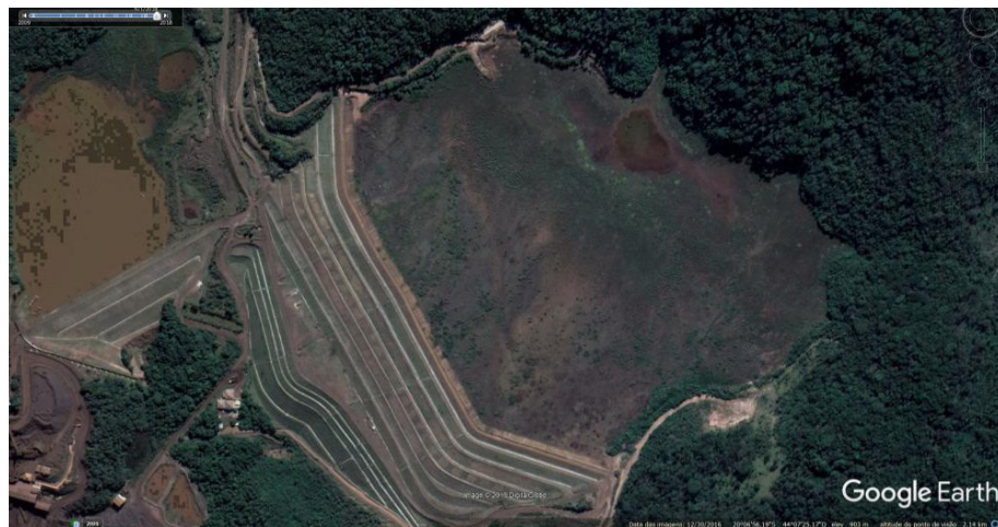
Figura 9 -Imagem de satélite da barragem I em 01/06/2018
