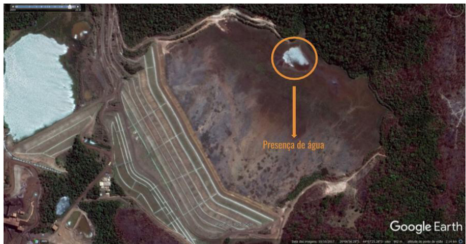
Figura 7 -Indícios de água na barragem I
