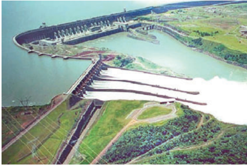
FIGURA 21 - Barragem e reservatório de Itaipu Fonte: Wikipedia.
