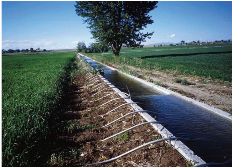
FIGURA 9 - Canal de irrigação com sifão Fonte: Wikipedia.
