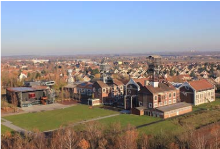
Figura 11 Sede da Mission Bassin Minier visto do alto da pilha de rejeito 9/9 bis Fonte: Renata Paranhos, jan/2020.
