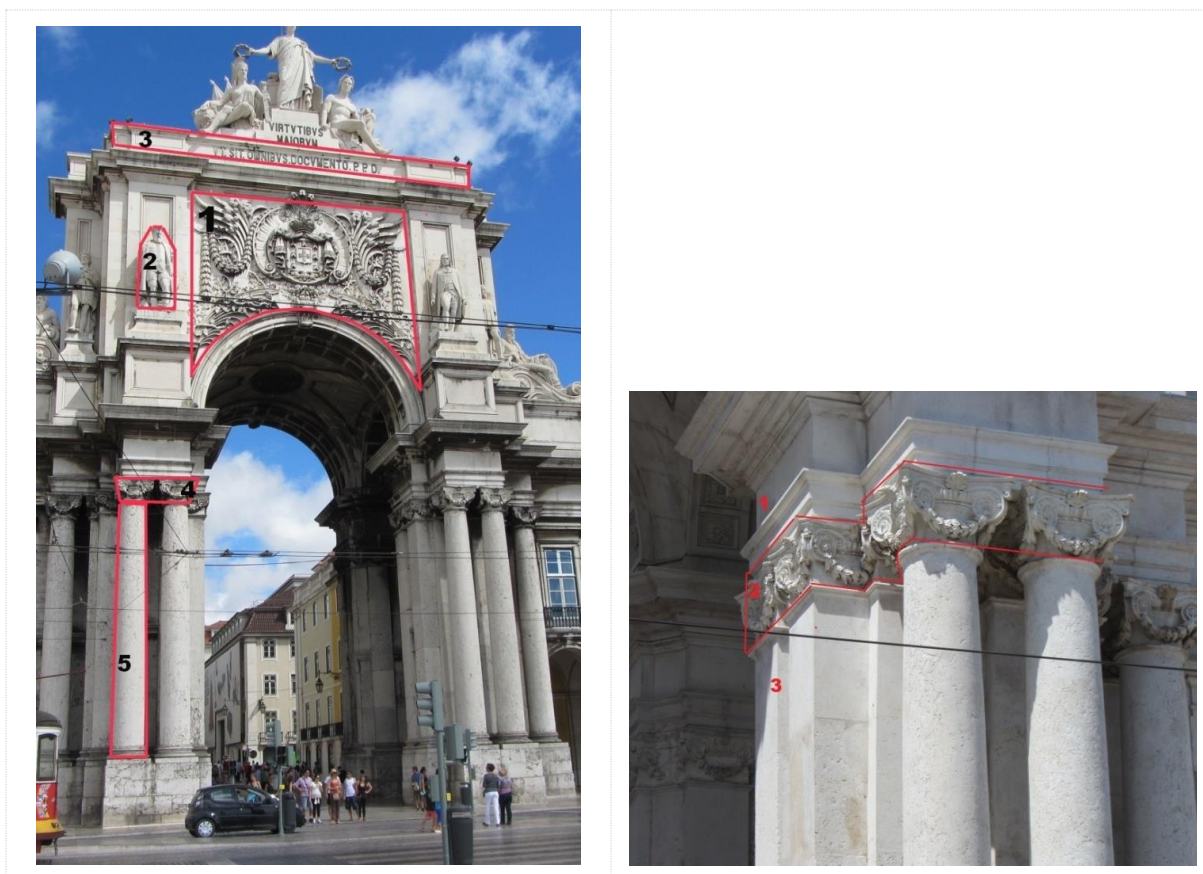
Figura 2. Arco da Rua Augusta, Lisboa. Visualização de unidades de intervenção caracterizadas por certa homogeneidade em termos da sua morfologia, problemas de deterioração e necessidades de conservação. A intervenção total era composta de 51 destas unidades. Adaptado de Delgado Rodrigues (2015)
