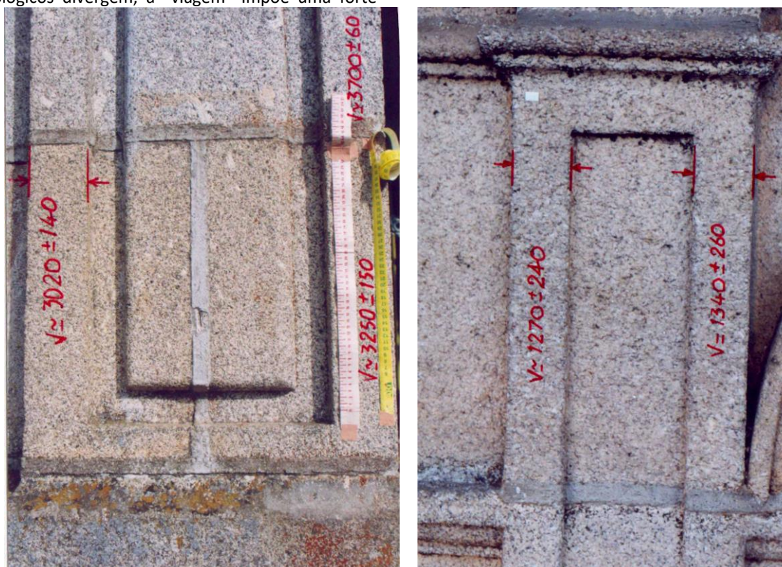
Figura 1. Velocidade de propagação de ultrassons ( V_L ) em elementos geométricos de um monumento em granito (igreja do Mosteiro de Tibães). Notem-se os valores elevados, no elemento da esquerda (da ordem dos 3000 m/s) e baixos, no da direita (da ordem dos 1340 m/s).
