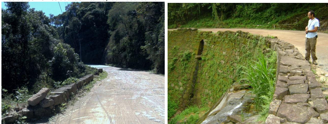
Figura 3. Calçamento e obras em pedra da Estrada Imperial em Mangaratiba (RJ). a) trecho preservado da pavimentação e muro de pedra próximo ao mirante; b) muro de arrimo em pedra adjacente à Cachoeira dos Escravos.
