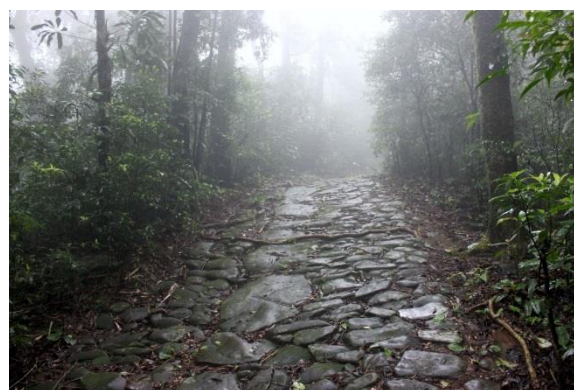
Figura 5. Calçada de Pedra em Magé-Teresópolis (RJ), na cota de 530m. Largura do pavimento, 4,5 m, com lajes maiores entre a lateral esquerda e o eixo da estrada.
