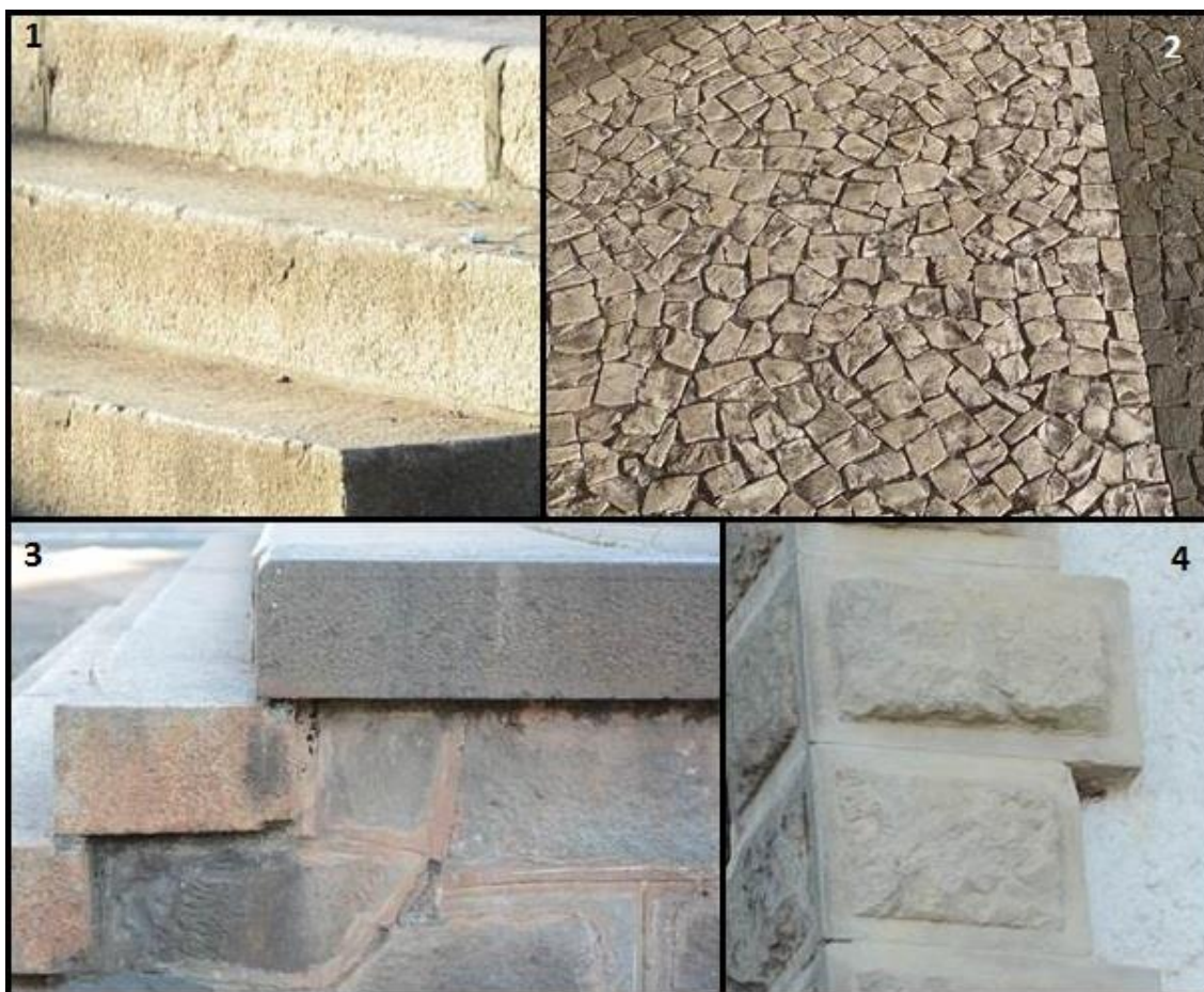
Figura 4.1. Escada de cantaria em diabásio; 2 – Petit pavé de metacalcário dolomítico; 3. Peças de cantaria em granito no terminal de carga de trens; 4. Cunhal da Casa de Memória em arenito. Foto: Alessi
