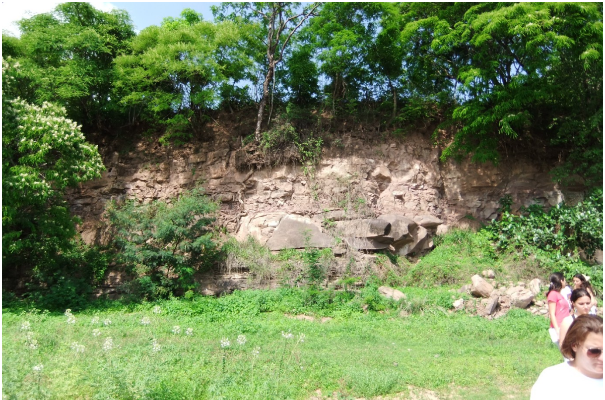
Figura 2 – visada SW-NE da escarpa de linha de falha erosiva, da base para o topo arcóseos dispostos em bancos com estratificação plano/paralela, arenitos finos, slititos com interlaminções finas (areia branca) e argilitos. Fonte: (Baggio, 2011).
