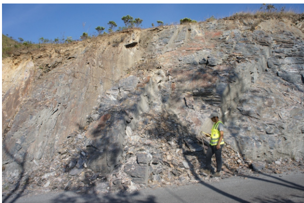
Foto 1 – Xistos com alta susceptibilidade a erosão, com deslocamento no sentido da foliação.
