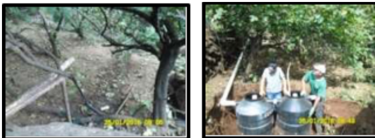
Foto 3: Propiedad sin sistema de saneamiento básico y después de la instalación Fuente: SUTRAF-AU, 2016.
