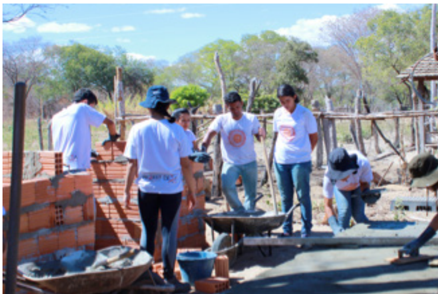
Figura 2: Discentes construindo o sistema de tratamento de água.
