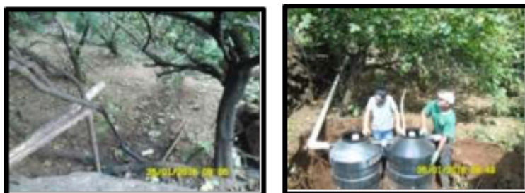
Foto 3: Propriedade sem sistema de saneamento básico e após a instalação Fonte: SUTRAF-AU, 2016.
