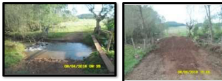
Foto 2: Antes de la instalación de puente para el paso de animales y máquinas
